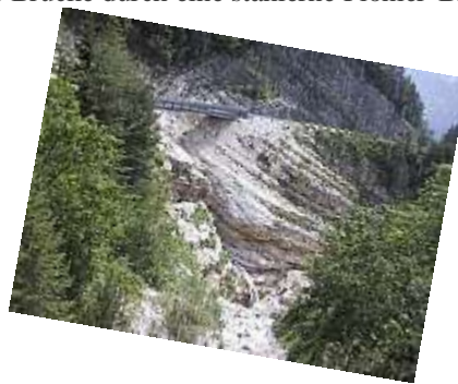
Pionierbrücke am Predilpass
